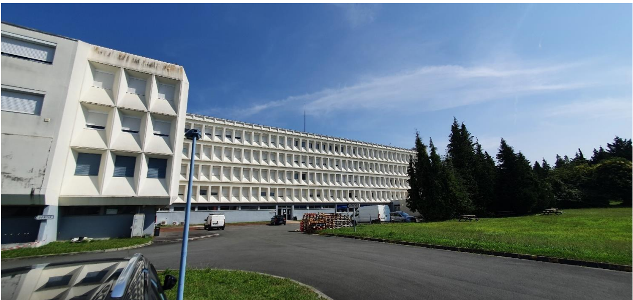
Zone d'implantation du bâtiment 15
