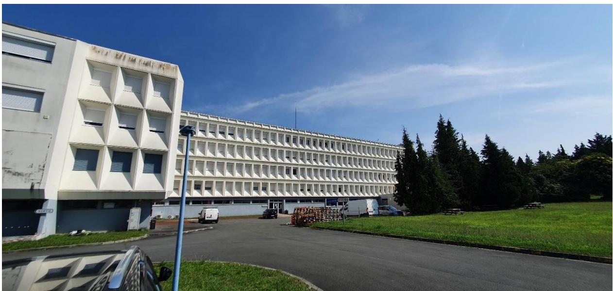
Zone d'implantation du bâtiment 15
